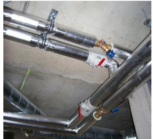
*Calorifuge en coquilles PIR, colliers isolants, et coquille adaptées pour les vannes.*
