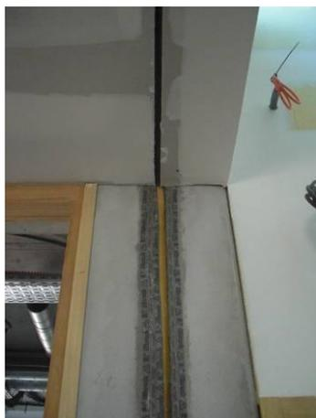
*Etanchéité à l'air d'un joint de dilatation par la pose d'une membrane*
