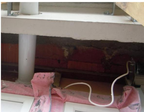
*Débord de dalle hourdi non enduit au niveau des volets roulants extérieurs : défaut d'étanchéité à l'air majeur. Un enduit a été réalisé. (hors AAP)*
