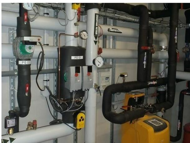
*Pompes de classe A, calorifuges complets, manomètres et thermomètres présents.*
