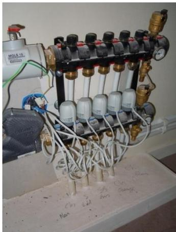
*Nourrices alimentant des radiateurs : les pièces desservies sont repérées au niveau hydraulique d'une part, et les fils reliés aux thermostats sont également repérés d'autre part, ce qui réduit le risque d'erreur.*
