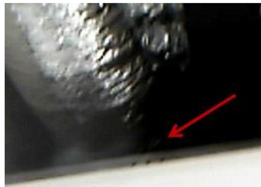
*Fuite à la liaison entre conduit souple et conduit rigide
