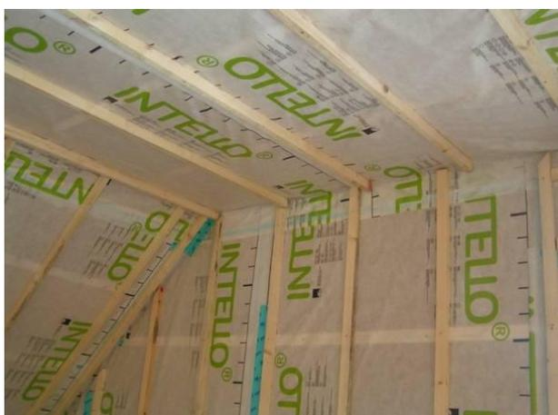
*Raccord des freine-vapeur entre toiture et murs.
