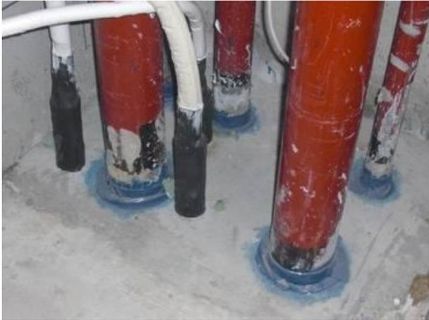
*Etanchéité à l'air au niveau des traversées de réseaux fluides par adhésif étirable.*
