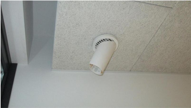
*Ci-contre : illustration concrète de « douche froide » : les bouches mises en œuvre sont de simple grilles orientées vers le bas. Celle-ci est située juste au-dessus d'un poste de travail. L'utilisateur a « bricolé » un déflecteur pour dévier le flux d'air sur le côté, pour améliorer son confort...*
