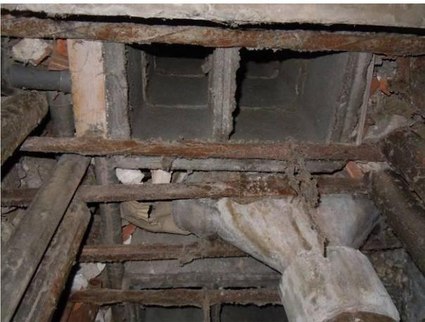
*Ci-contre : Pieds de conduit shunt non rebouchés (depuis la construction !). Tout le tirage thermique permettait de ventiler... une cave, et non les logement ! (hors AAP)*
