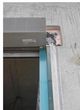
*Coffre de volet roulant extérieur, avant ITE.*
