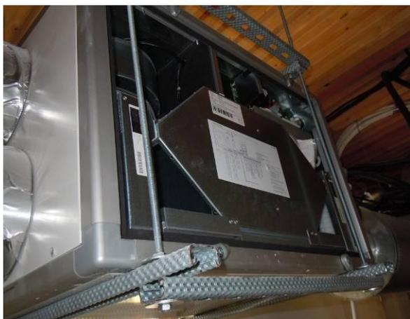
*Les suspentes gênent l'ouverture de la porte, et empêchent de sortir les filtres.*
