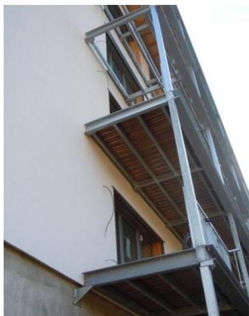
*Balcon semi-porté, en structure métallique et platelage bois*
