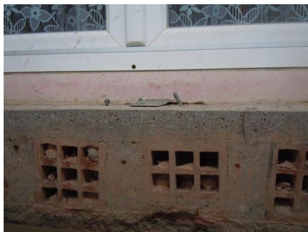
*Balcon en poutrelle hourdis scié pendant la rénovation : défaut d'étanchéité à l'air majeur. Un enduit ciment a été réalisé. (hors AAP)*
