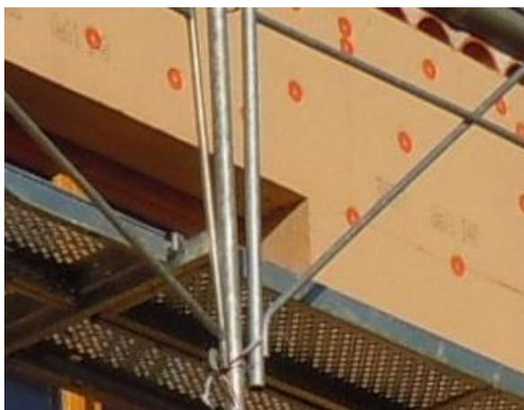
*Pose non conforme aux règles de l'art : joint en angle de la menuiserie, et chevillage en joint non conforme pour un isolant souple (hors AAP).*
