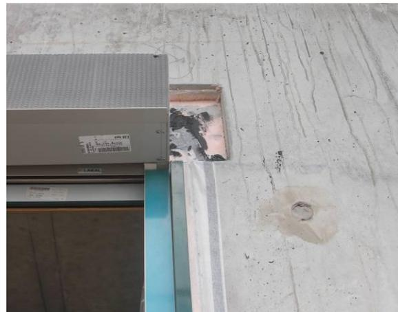
Exemple de détail de traitement du pont thermique du volet roulant extérieur.
