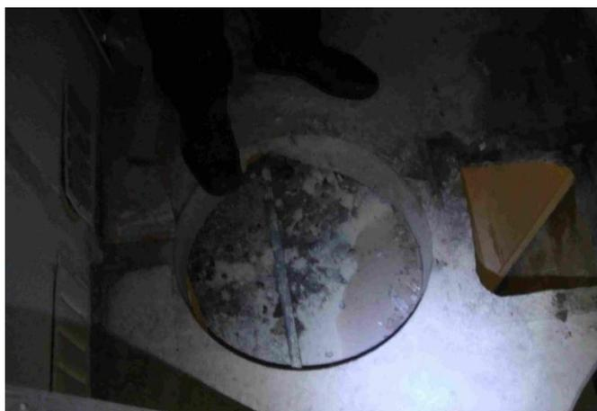
*Conduit de dalle active sectionnée lors d'un carottage de dalle.*
