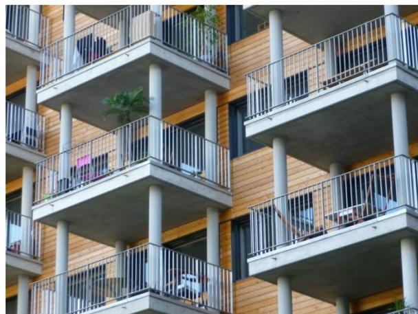
*Balcon totalement désolidarisé (hors AAP) : noter que leur taille permet d'y placer une table*
