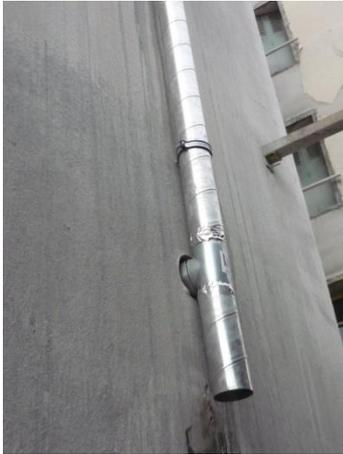
*Réseau réalisé par l'extérieur, dans l'épaisseur de l'ITE (hors AAP)*
