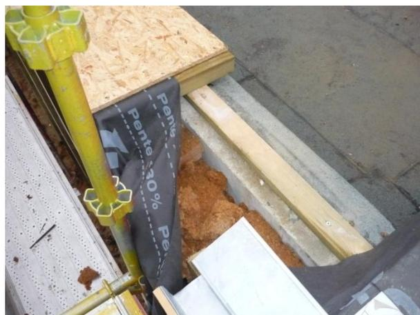
*Défaut de protection des ouvrages : isolant dégradé.*
