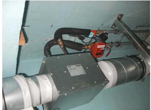
*Chauffage complémentaire à la dalle active réutilisée, par batterie hydraulique sur le soufflage de la ventilation double flux.*
