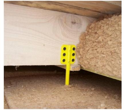
*Exemple d'isolation en rampant avec support à faible pont thermique*
