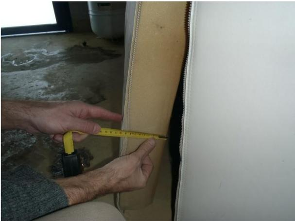
*Isolation d'un ballon ECS par 10 cm d'isolant performant. Vérifier aussi le dessus et le dessous !*
