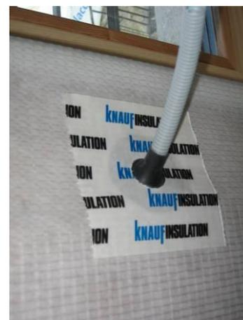
*Schéma du traitement de l'étanchéité à l'air au passage d'un fourreau électrique*
