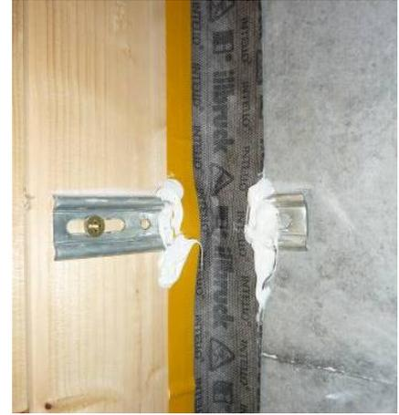
*Menuiserie en applique intérieure : les équerres gênent la pose de la membrane (hors AAP)*
