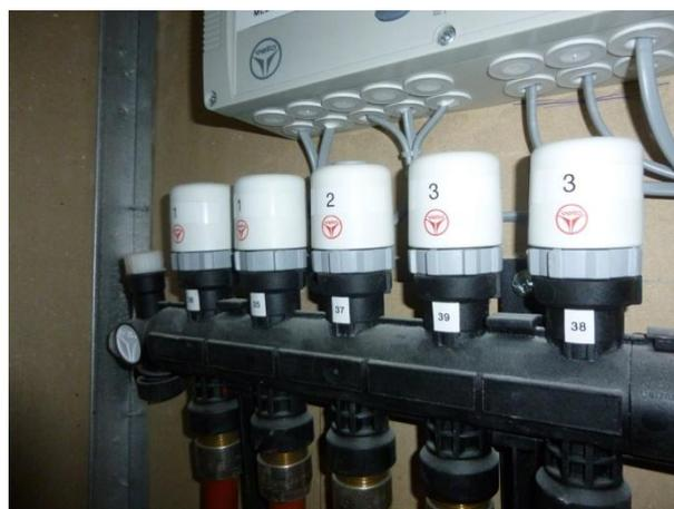
*Vannes électrothermiques pilotées par thermostat, sur nourrice de plancher chauffant*
