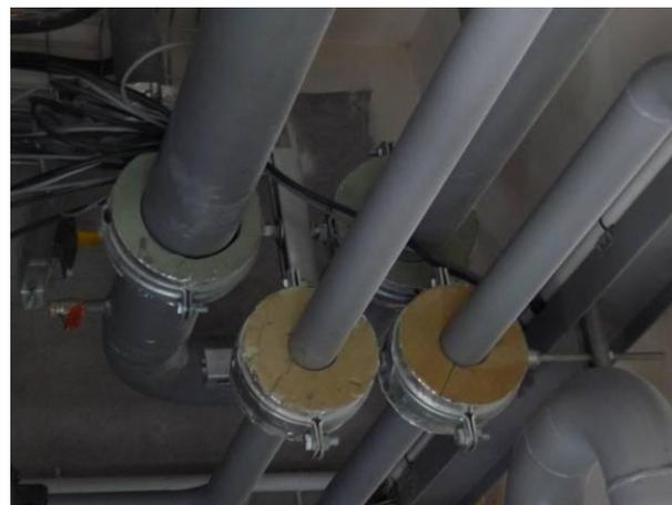
Calcul des déperditions d'un collier nu par éléments finis : l'augmentation des déperditions linéaires est de +15% en moyenne
