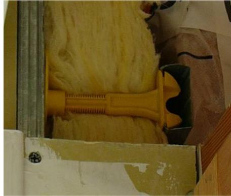
*Exemple d'isolation par l'intérieur avec appui à faible pont thermique*
