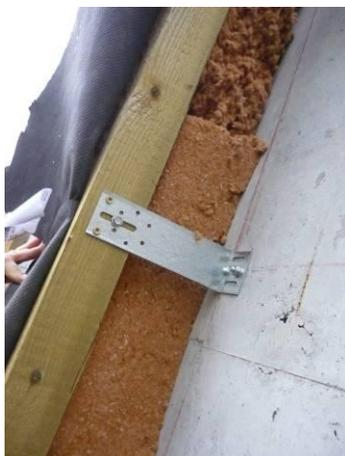
*Exemple d'ITE avec équerre traversant tout l'isolant*
