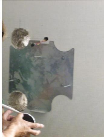
*Ventilation double flux décentralisée (hors AAP) : prise d'air et rejet se font à travers le mur. Photo des carottages et de la platine, puis pose du caisson.*
