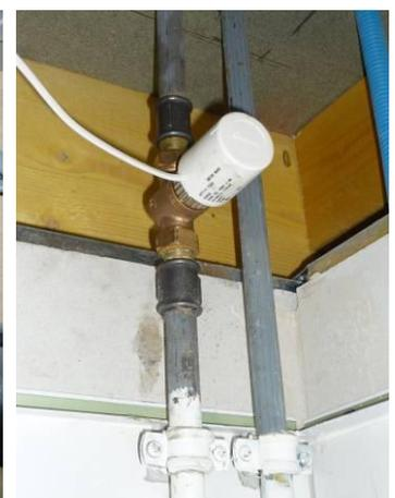
*Vannes électrothermiques en faux plafond*
