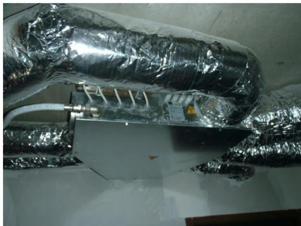
*Batteries hydrauliques pour le chauffage d'un logement*
