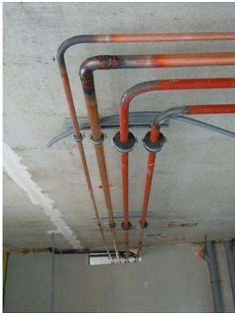
*Réseau en cours, avec coller isolant et réservation dans le mur suffisante pour le calo.*
