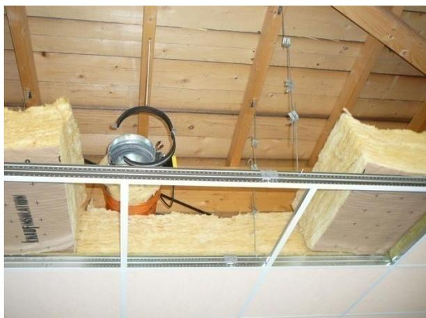
*Faux plafond avec suspentes : pose d'un freine-vapeur impossible*
