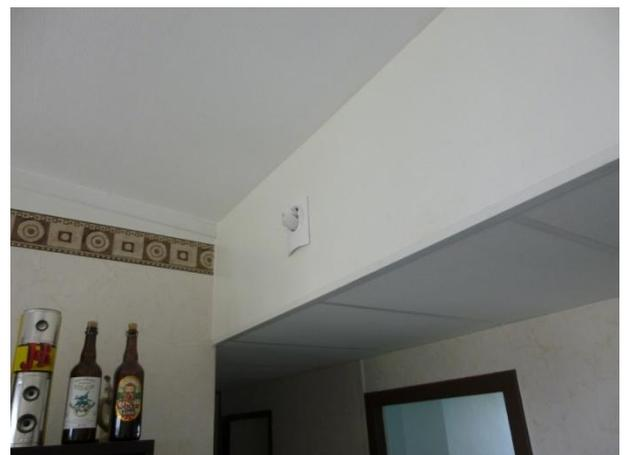
*Faux plafond (démontable) et bouche de soufflage mis en œuvre en rénovation.*
