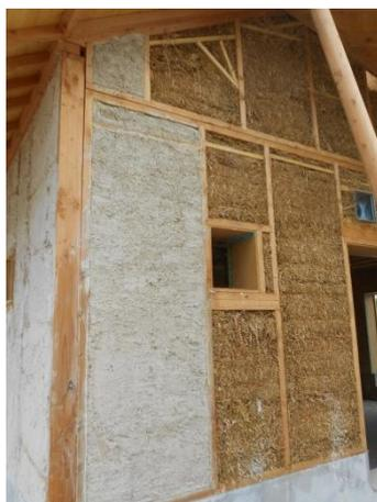
*Bâtiment tertiaire isolé avec des bottes de paille. Enduit extérieur en cours.*
