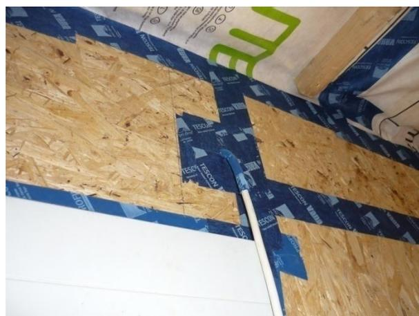
*Etanchéité à l'air d'un mur à ossature bois réalisé par les panneaux OSB.*
