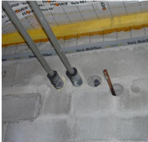
*Continuité partielle de l'isolant à la traversée d'un refend (calorifuge moins bon qu'en partie courante.*
