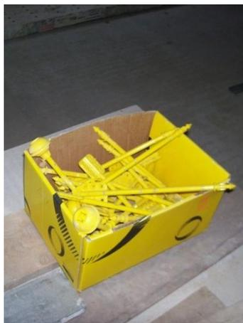
*Suspentes à faibles ponts thermiques structurels approvisionnés pour isolation en rampant.*
