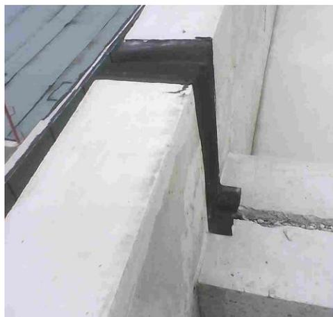
*Etanchéité à l'air en cours sur l'acrotère au niveau d'un joint de dilatation (hors AAP).*
