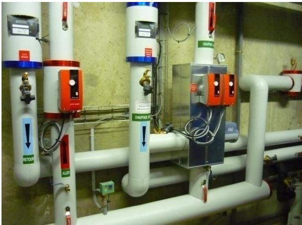
*Exemple de calorifuge complet d'une chaufferie*
