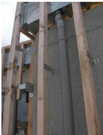
*Equerres métalliques traversant la future ITE + chute d'eaux pluviales.*
