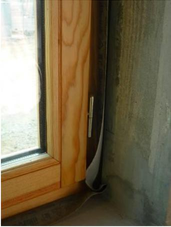
*Pose d'une membrane d'étanchéité avec bande butyl sur béton ou agglo enduit*
