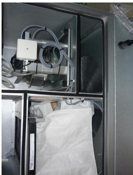
**Ventilation mécanique contrôlée double flux** : la ventilation double flux avec récupération de chaleur reste le moyen le plus simple de récupérer la chaleur de l'air extrait. Cette récupération est assurée par un échangeur, qui peut être à plaques ou à roue, et qui réchauffe l'air soufflé avec l'air extrait (en hiver, sachant que l'inverse se produit en été). On peut ainsi récupérer plus de 85% de la chaleur de l'air extrait.
