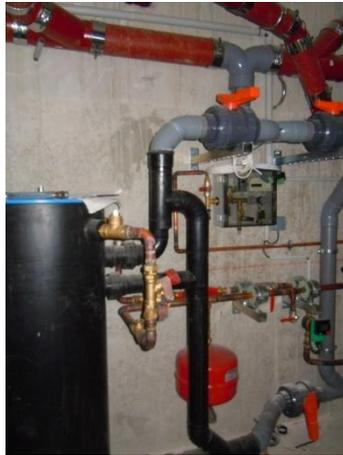
*Récupérateur sur eaux grises avec stockage (avant calorifugé)*
