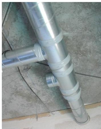
*Piquages réalisés avec pièces de transformation, et bande de recouvrement butyl : bonne étanchéité.*
