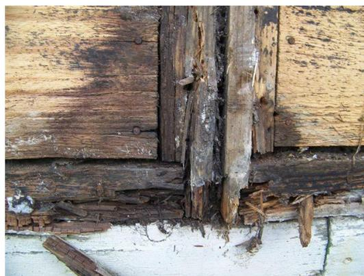
*Dégradation des soubassements d'une maison à ossature bois par condensations dues aux infiltrations/exfiltrations d'air au droit d'une fuite (Photo : Alsatech)*
