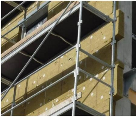
*Exemple d'isolation par l'extérieur avec chevilles à faible pont thermique*
