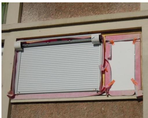
*Menuiserie monobloc avec coffre de volet roulant extérieur (avant raccordement des membranes et pose de l'ITE) (hors AAP)*
