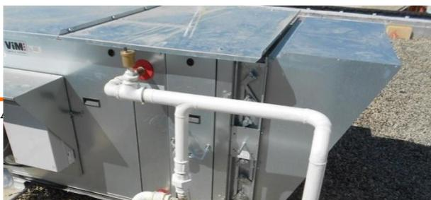
*Batterie de préchauffage sur l'air de compensation pour une cuisine pédagogique (avant calorifuge...).*
