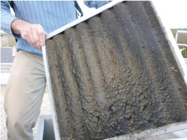
*Filtre d'air neuf encrassé (pré-filtre en toiture sur une installation à échangeurs individuels)*
