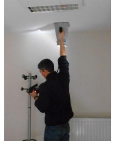
*NB : comme on le voit, contrairement à l'équilibrage hydraulique, l'équilibrage du réseau de ventilation n'est pas nécessairement à réaliser avant le réglage de la consigne. Au contraire, il sera plus facile de régler les iris en fonction de la pression aux bouches des différentes branches après réglage de la consigne de la CTA sur la branche la plus défavorisée.*
