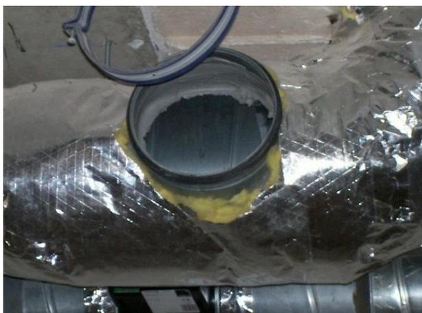
*Piquage par découpe et pose de collerette : source d'inétanchéité à l'air et de pertes de charges.*
