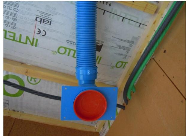
*Réseau semi-rigide plastique : assemblage par pièces à joint du fabricant. Bonne étanchéité.*
