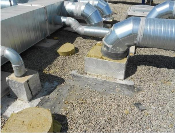
Relevé d'étanchéité sur cadre métallique rempli d'isolant.
